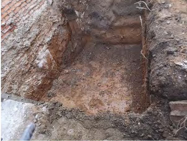
FOTO 73. Rebaix del pou per la construcció de l'ascensor.
