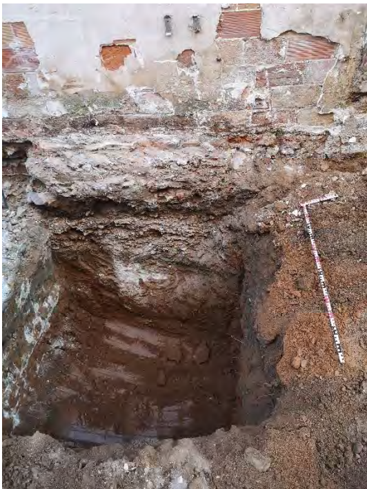
FOTO 39. Ampliació del tram 1 de la sabata est.
