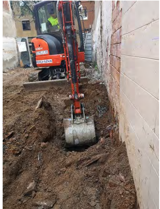
FOTO 22. Rebaix del tram 3 de la sabata oest.
