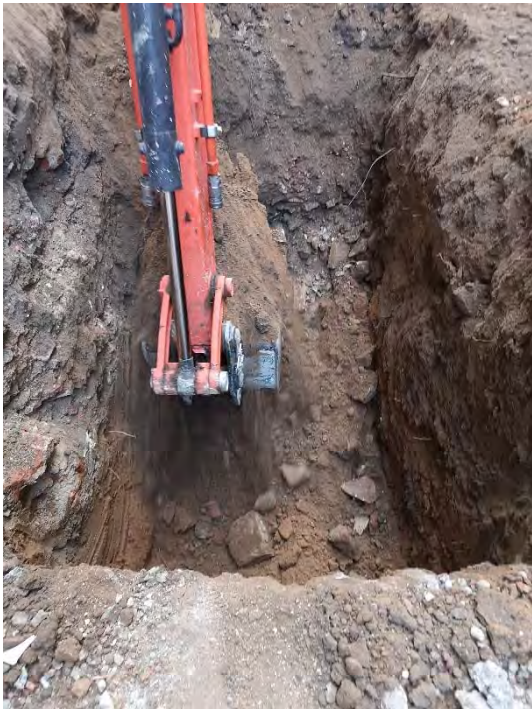
FOTO 69. Rebaix del pou per la construcció de l'ascensor.
