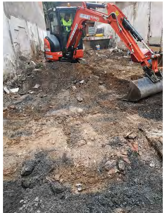
FOTO 08. Rebaix de la capa superficial de terres del solar.
