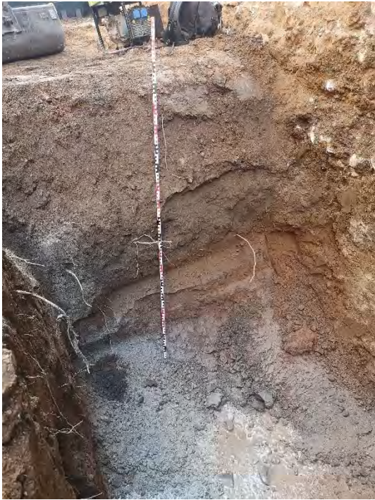
FOTO 17. Estratigrafia sud ampliació del tram 1 de la sabata oest.
