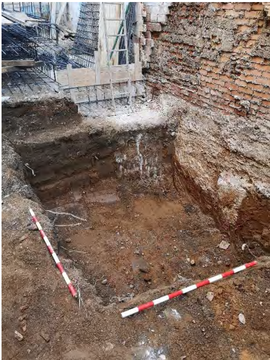
FOTO 75. Detall del pou per la construcció de l'ascensor.
