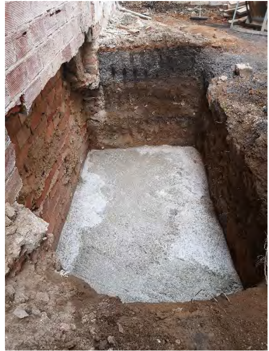
FOTO 14. Detall del tram 1 de la sabata oest amb formigó.
