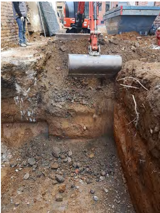
FOTO 51. Rebaix de la sabata central.
