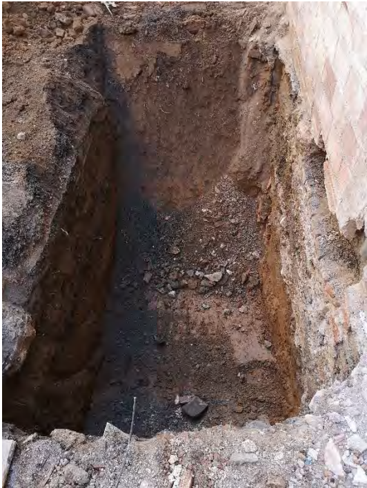
FOTO 09. Rebaix del tram 1 de la sabata oest.
