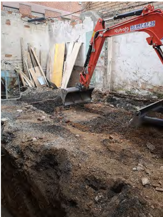
FOTO 31. Rebaix del tram 1 de la sabata est.
