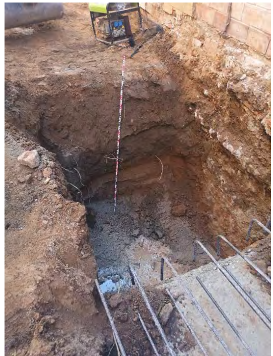
FOTO 16. Ampliació del tram 1 de la sabata oest.
