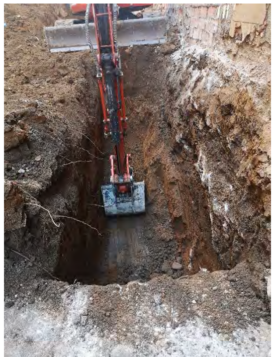
FOTO 20. Rebaix del tram 2 de la sabata oest.
