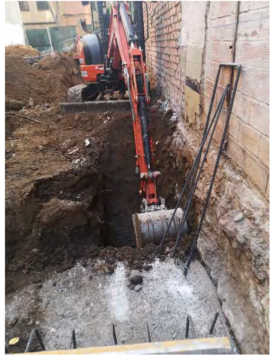
FOTO 18. Rebaix del tram 2 de la sabata oest.
