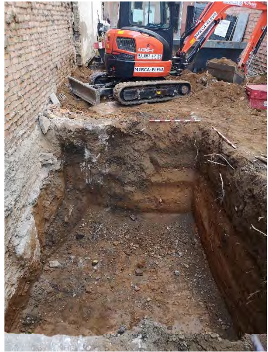
FOTO 74.. Detall del pou per la construcció de l'ascensor.
