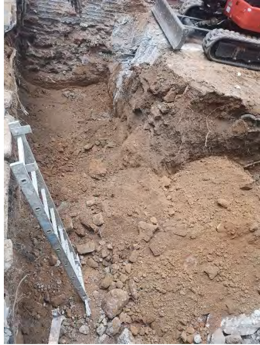
FOTO 62. Rebaix de la riosta situada al sud del solar.
