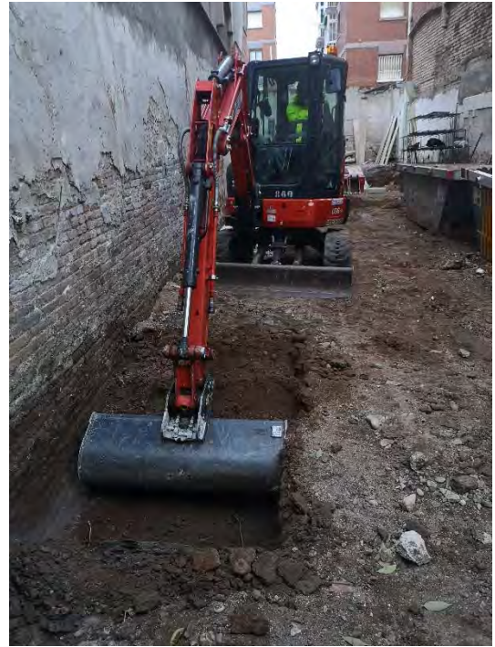
FOTO 26. Rebaix del tram 4 de la sabata oest.
