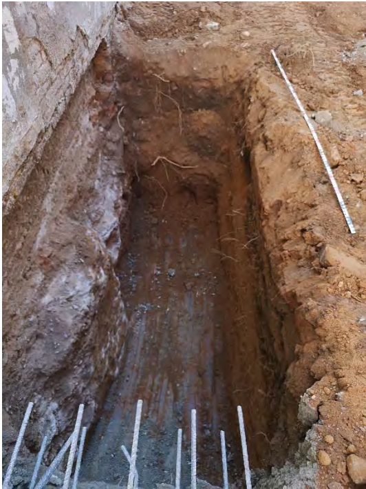
FOTO 49. Detall del tram 3 de la sabata est.
