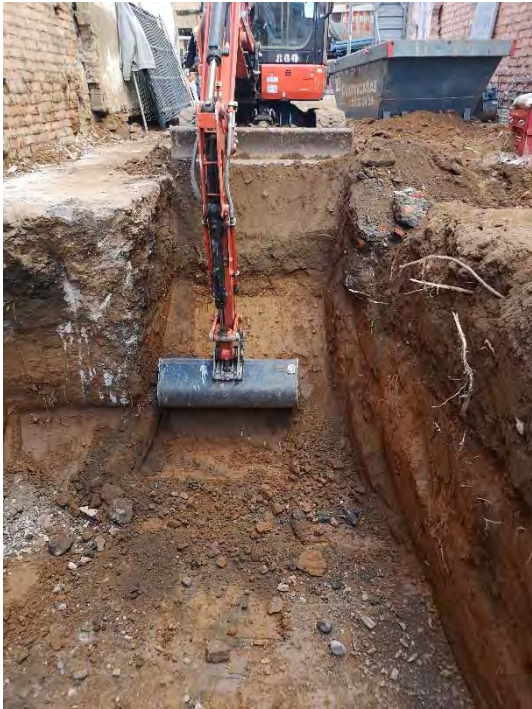
FOTO 53. Rebaix de la sabata central.
