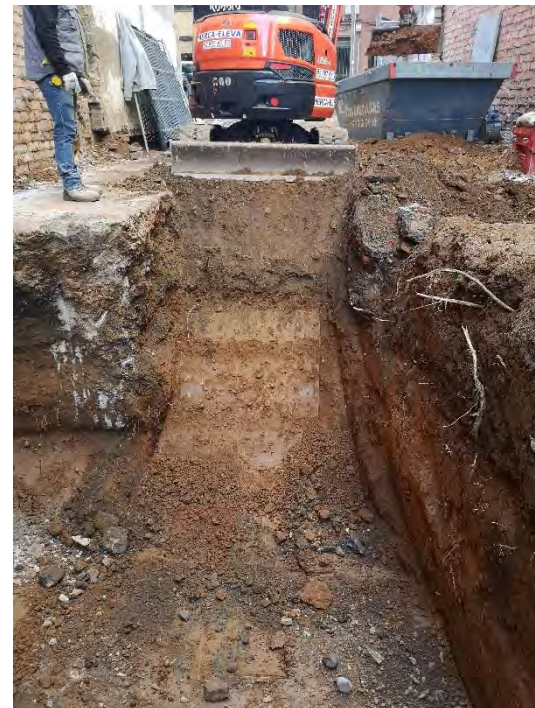
FOTO 52. Rebaix de la sabata central.
