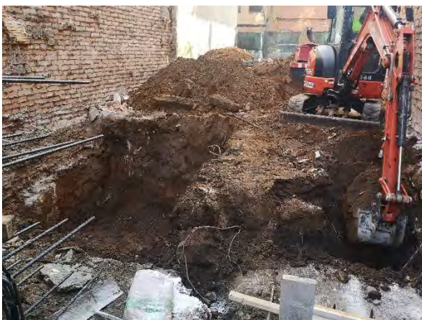
FOTO 19. Rebaix del tram 2 de la sabata oest.
