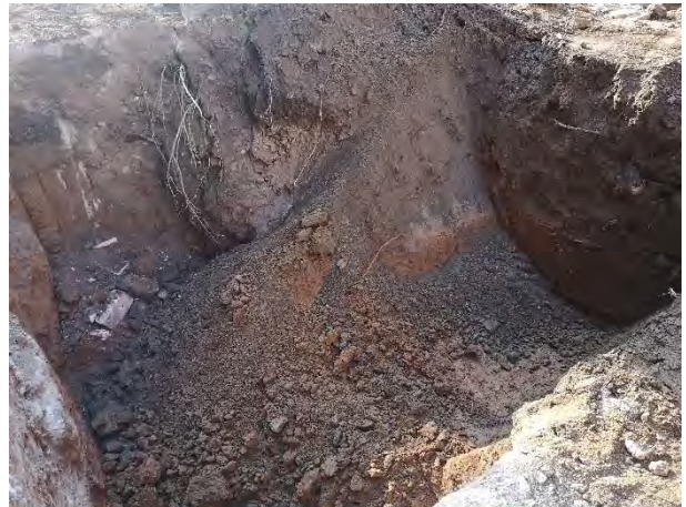
FOTO 70. Rebaix del pou per la construcció de l'ascensor.
