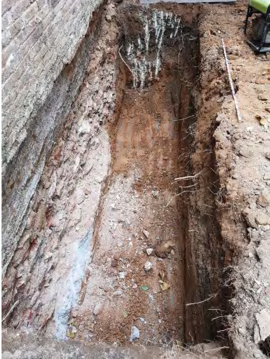
FOTO 29. Detall del tram 4 de la sabata oest.
