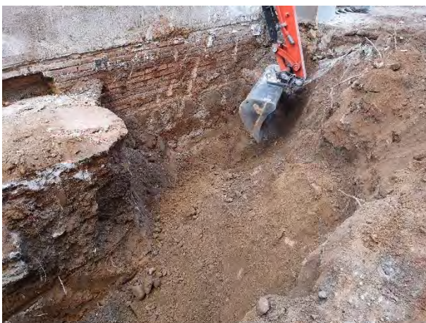
FOTO 59. I FOTO 60. Rebaix de la part sud de la sabata central i del tram 3 de la sabata est.
