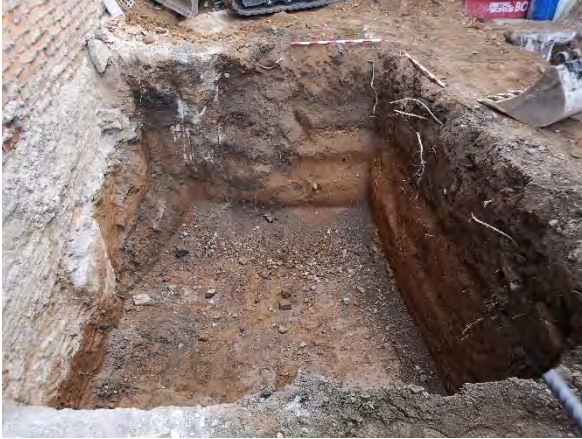
FOTO 77. Detall del pou per a la construcció de l'ascensor.
