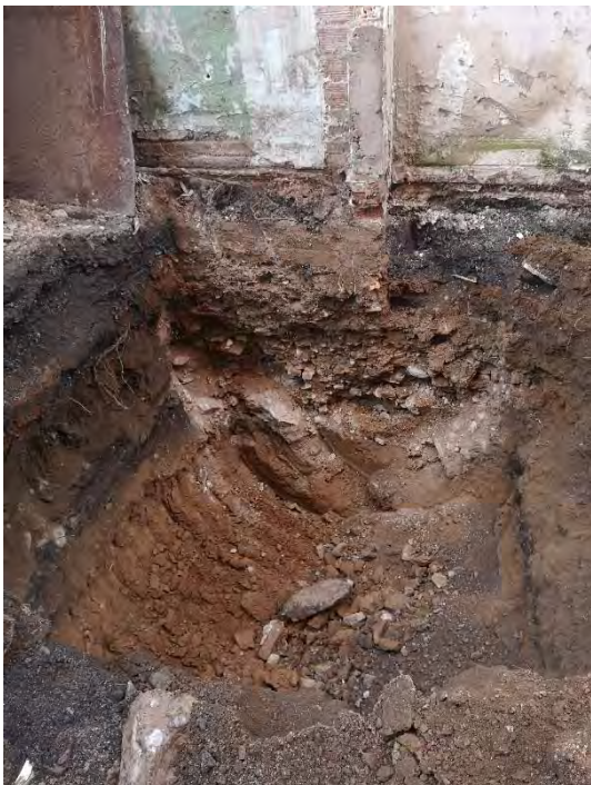
FOTO 35. Rebaix del tram 1 de la sabata est.
