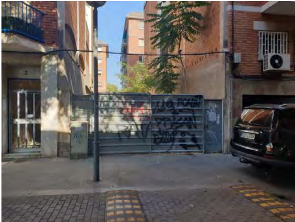
FOTO 01. Detall del solar del carrer de l'Estadella num.5.
