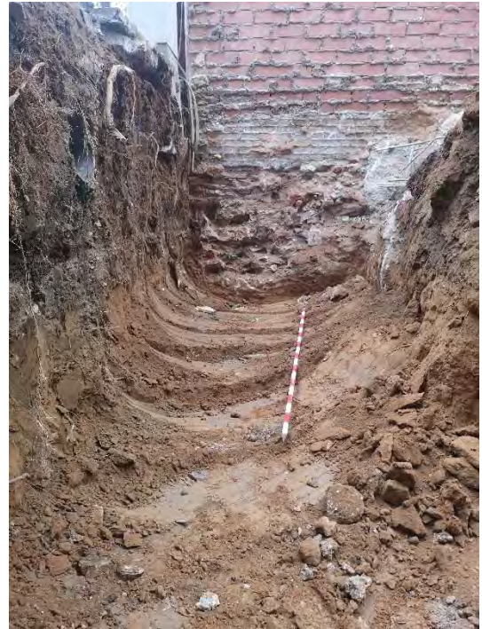
FOTO 66. Detall de la riosta situada al sud del solar.
