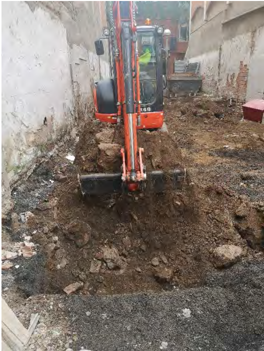
FOTO 33. Rebaix del tram 1 de la sabata est.
