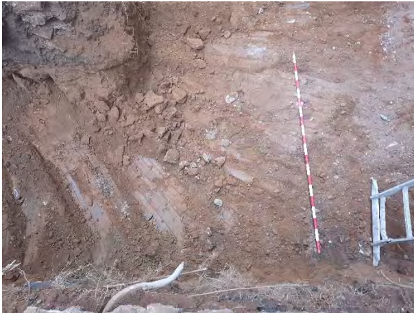
FOTO 65. Detall de la riosta situada al sud del solar.
