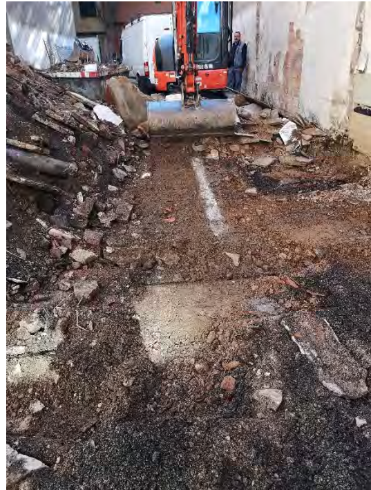
FOTO 06. Rebaix de la capa superficial de terres del solar.
