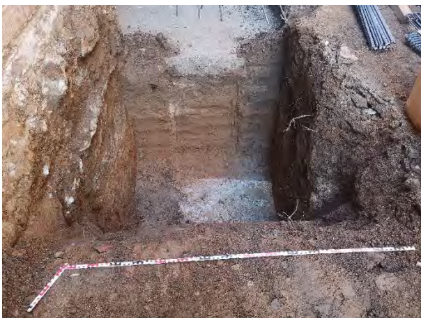
FOTO 15. Ampliació del tram 1 de la sabata oest.
