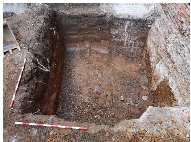
FOTO 76. Detall del pou per la construcció de l'ascensor.
