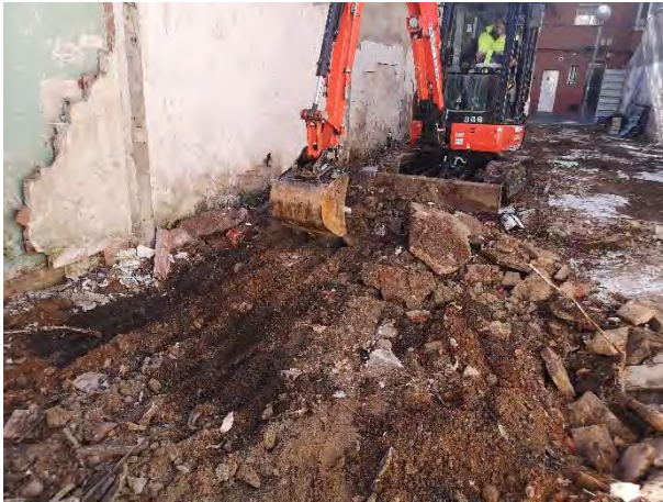
FOTO 05. Rebaix de la capa superficial de terres del solar.
