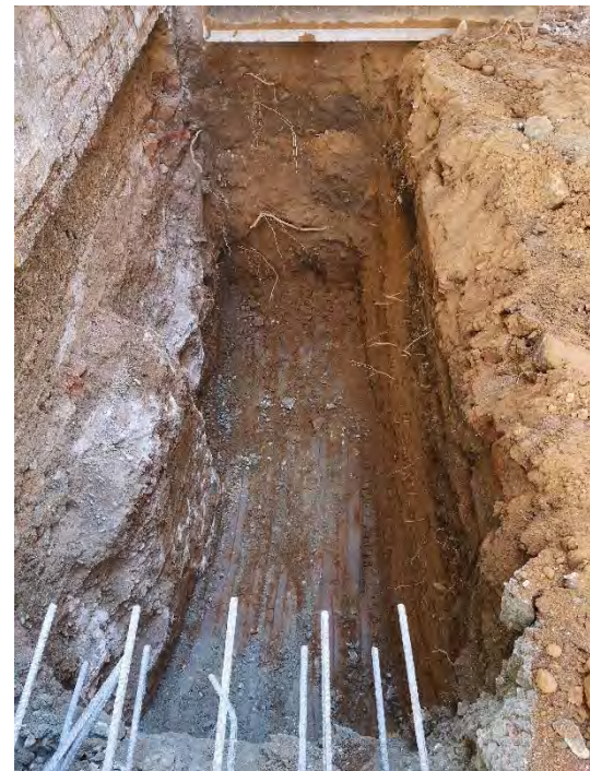
FOTO 48. Rebaix del tram 3 de la sabata est.
