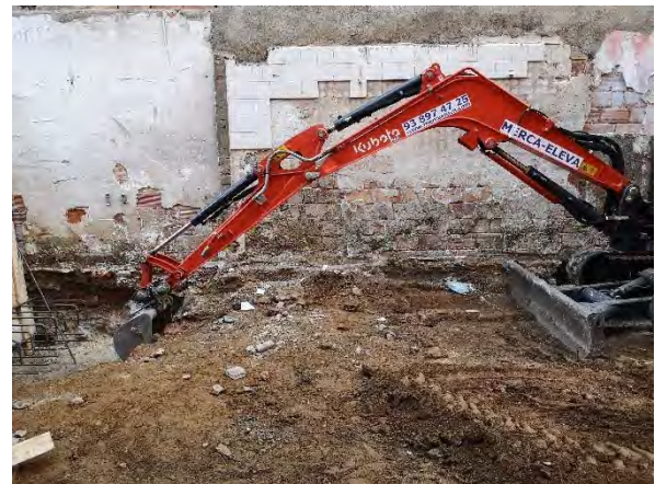
FOTO 68. Rebaix del pou per la construcció de l'ascensor.
