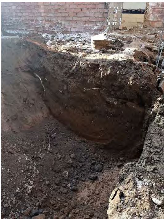
FOTO 71. Rebaix del pou per la construcció de l'ascensor.
