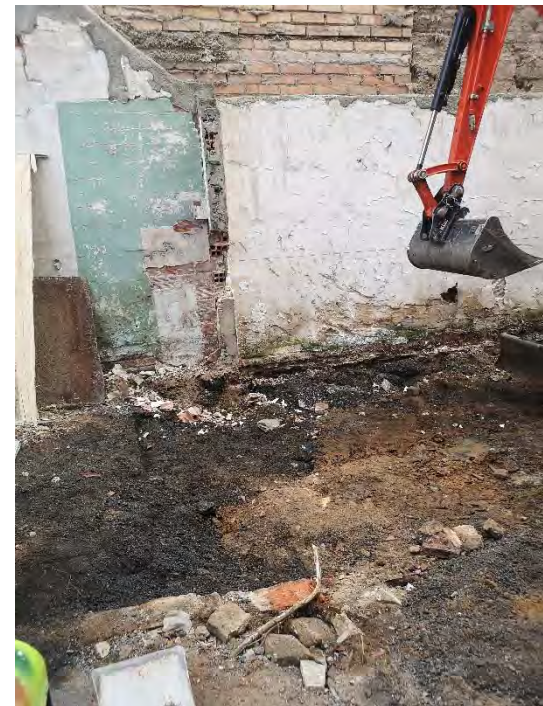
FOTO 32. Rebaix del tram 1 de la sabata est.
