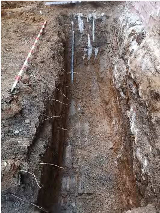
FOTO 21. Detall del tram 2 de la sabata oest.
