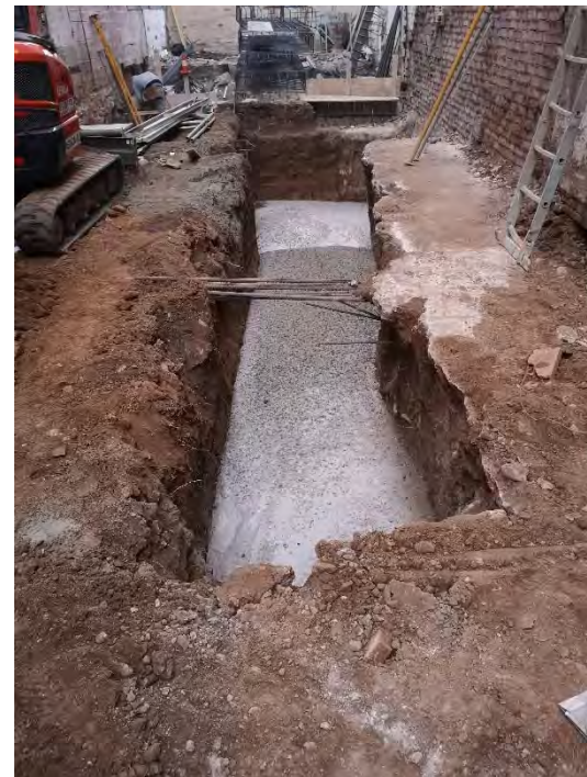
FOTO 56. Detall de la sabata central amb formigó.
