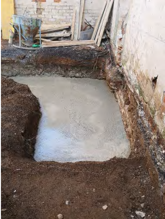
FOTO 37. Detall del tram 1 de la sabata est amb formigó.
