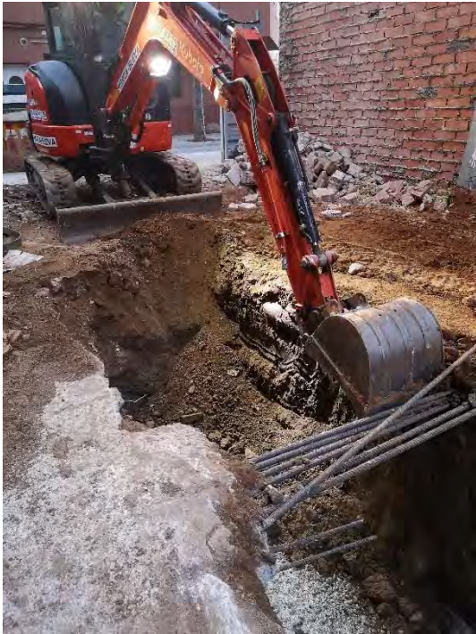
FOTO 57. Rebaix de la part sud sabata central.
