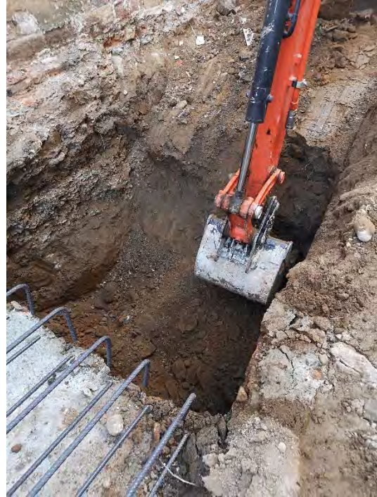
FOTO 38. Ampliació del tram 1 de la sabata est.
