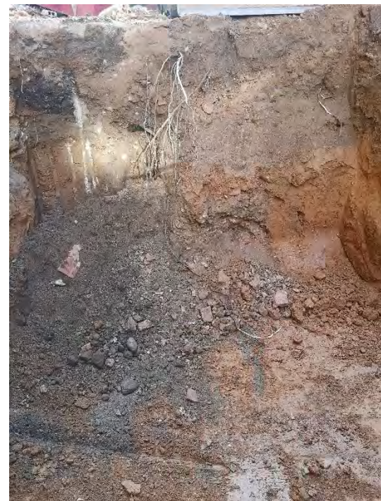
FOTO 72. Rebaix del pou per la construcció de l'ascensor.
