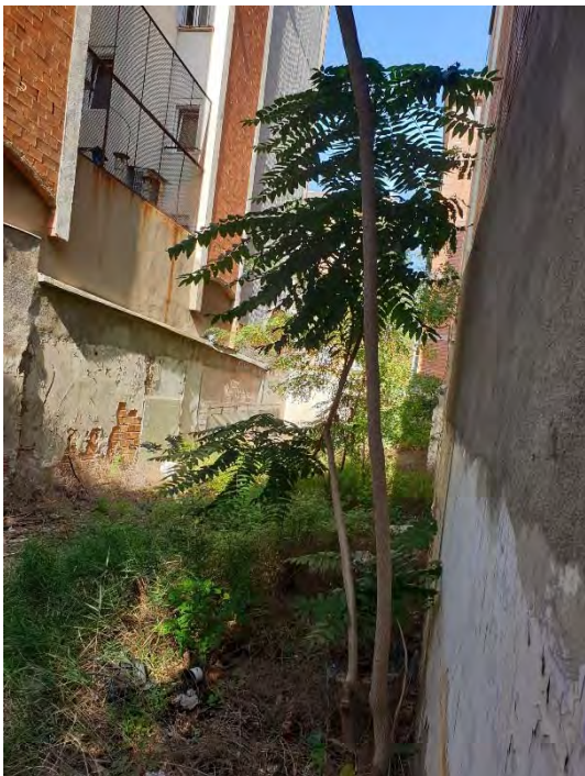
FOTO 03. Detall del solar abans de la intervenció.
