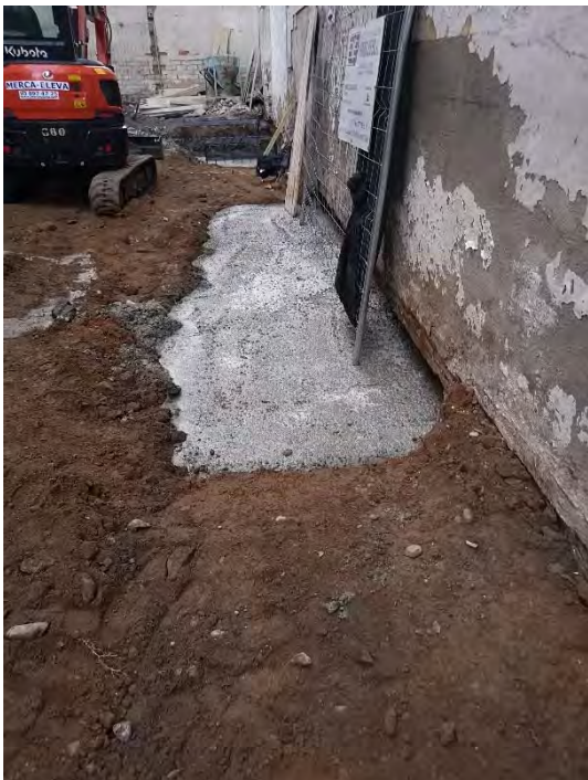
FOTO 47. Detall del tram 2 de la sabata est amb formigó.
