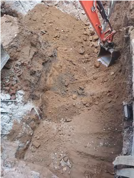
FOTO 63. Rebaix de la riosta situada al sud del solar.
