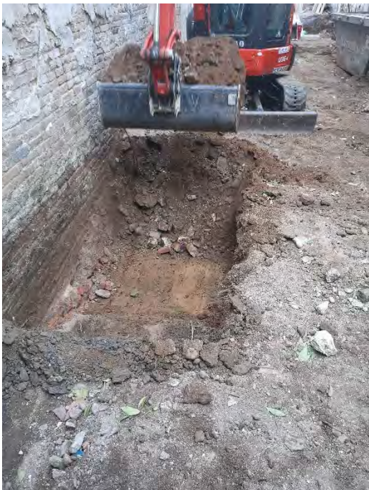
FOTO 27. Rebaix del tram 4 de la sabata oest.
