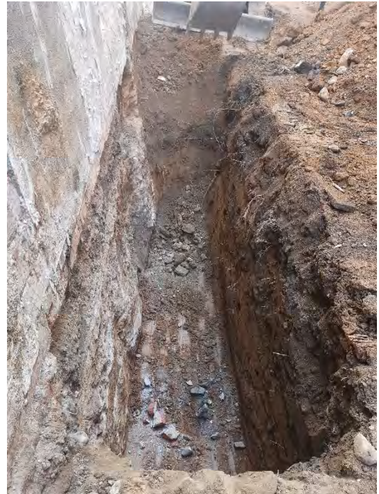
FOTO 42. Rebaix del tram 2 de la sabata est.
