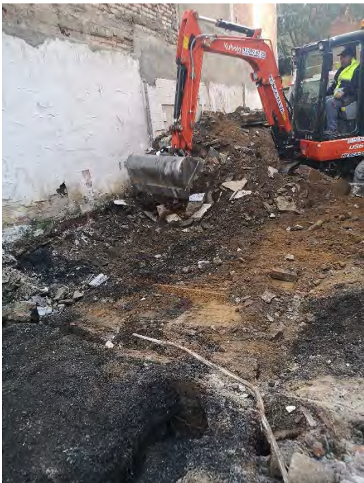
FOTO 07. Rebaix de la capa superficial de terres del solar.
