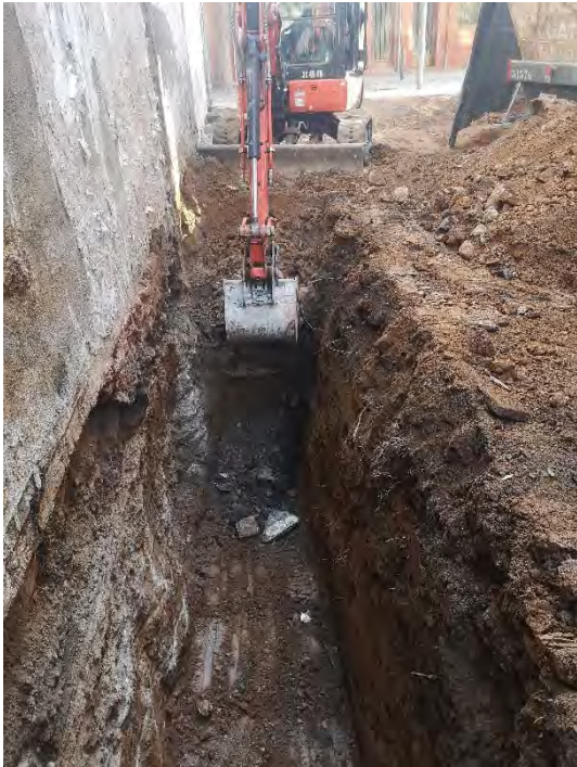
FOTO 41. Rebaix del tram 2 de la sabata est.
