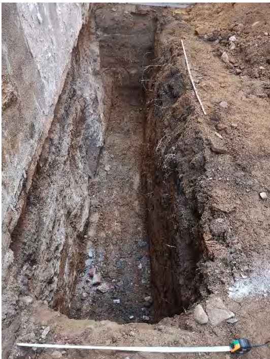
FOTO 43. Detall del tram 2 de la sabata est.
