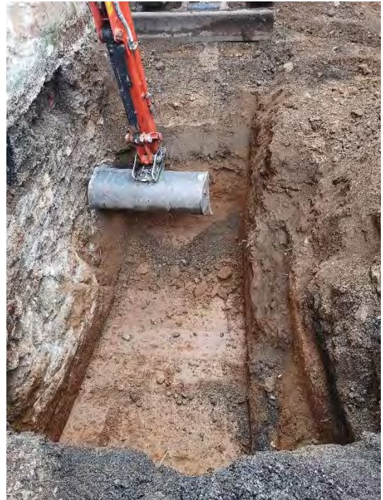
FOTO 34. Rebaix del tram 1 de la sabata est.
